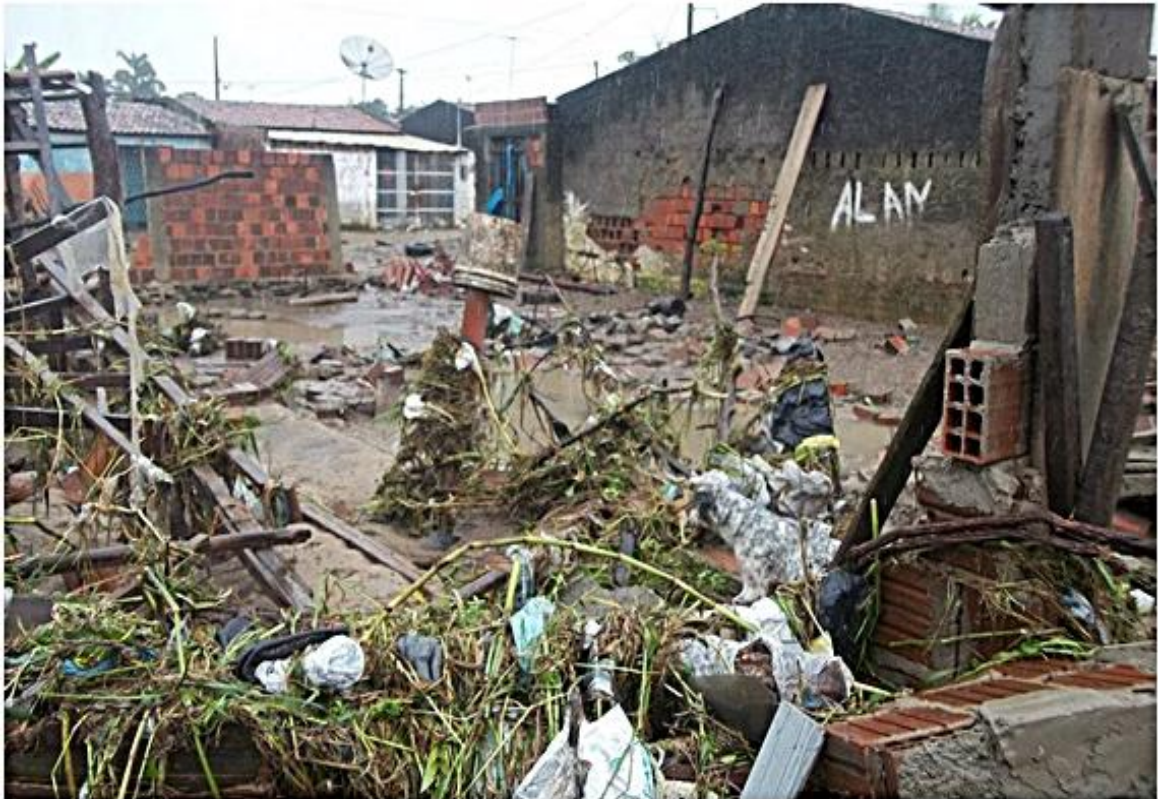
FIGURA 14: Registro fotográfico que retrata a destruição da casa de alguns moradores.
