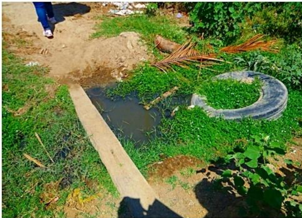
FIGURA 35: Ponte improvisada de transição entre ruas.
