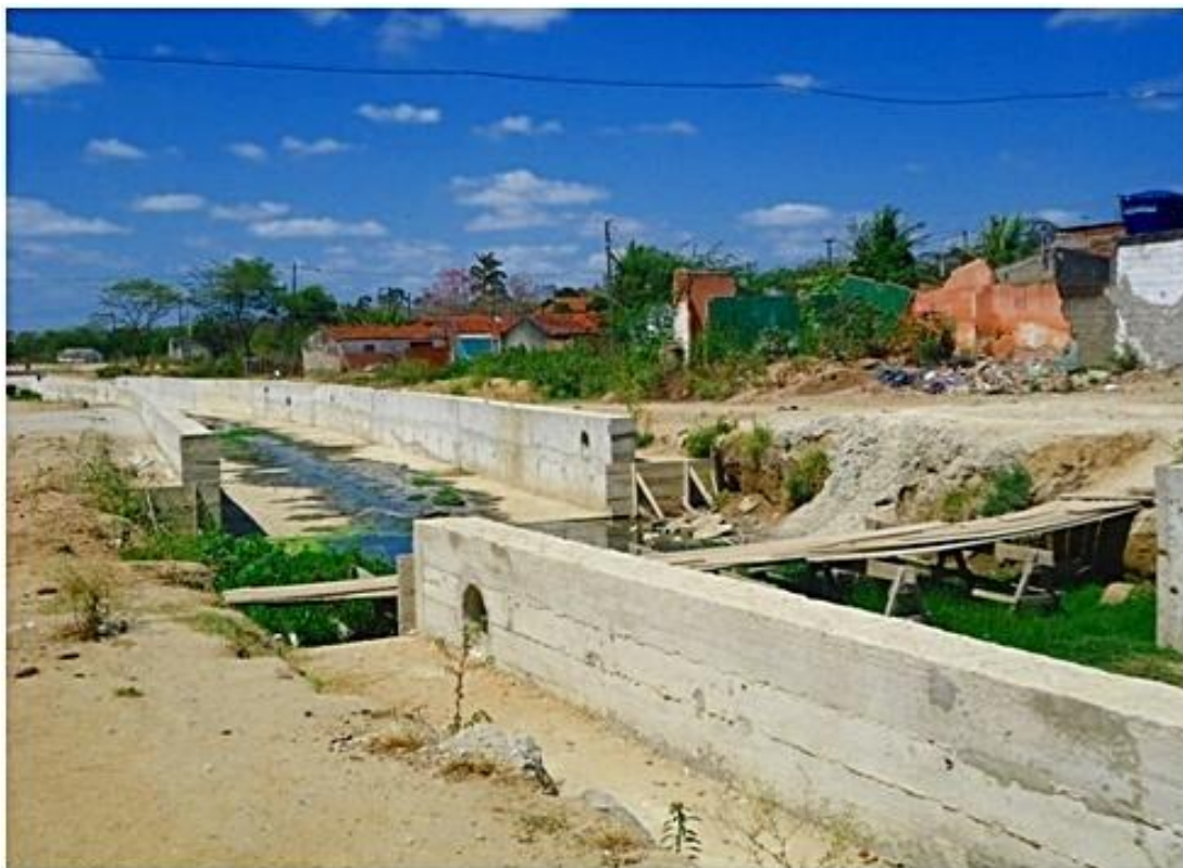
FIGURA 32:Obras da construção do canal e pontes improvisadas.
