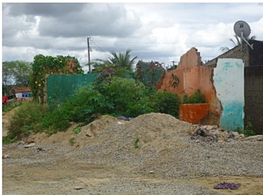
FIGURA 31: Casa de D.E.G. destruída pela enchente de 2011.
