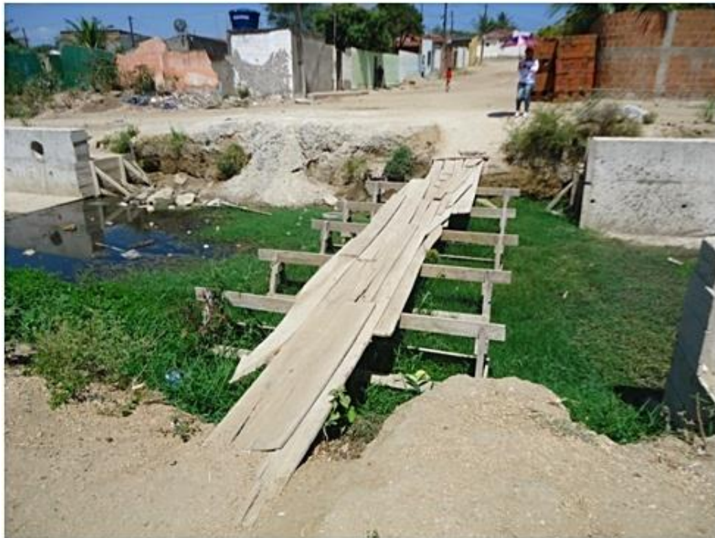
FIGURA 34: Ponte improvisada para transição na comunidade. Ao fundo casas afetadas pela enchente.
